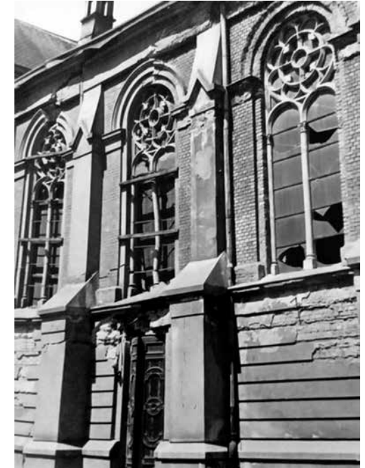
Popękane mury kościoła pw. św. Henryka (foto AB)
