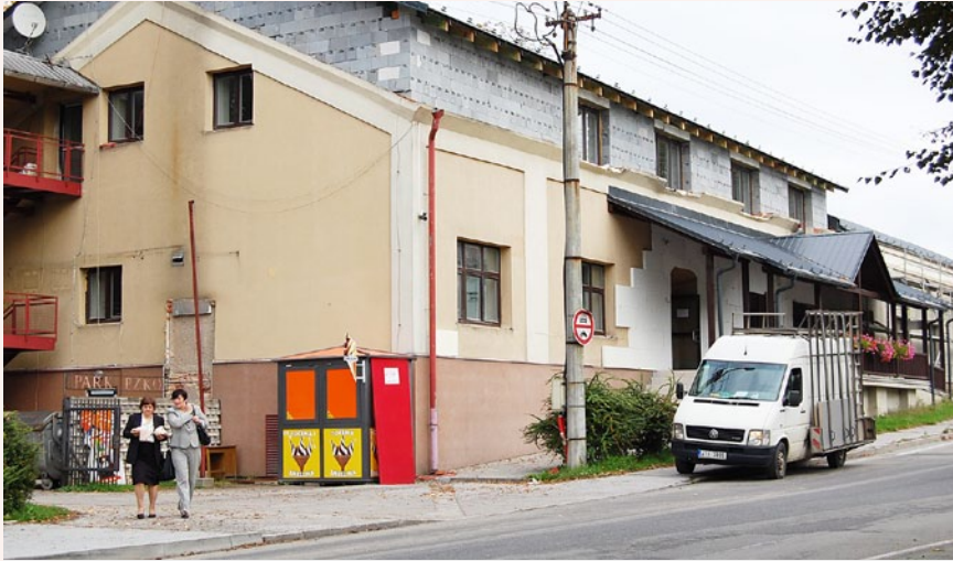
Stonawski Dom PZKO w remoncie
